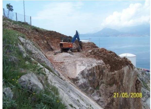
Fasi di demolizione con il ragno
