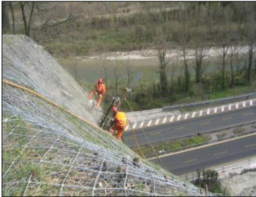
Fasi di perforazione per la posa degli ancoraggi del consolidamento
