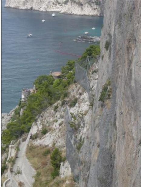
Posa in opera di barriere paramassi ad alto assorbimento energetico
