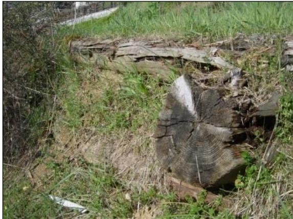
Completo deterioramento della palificata esistente
