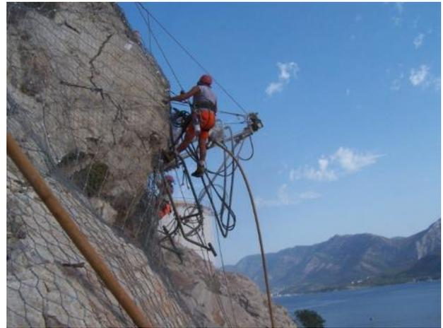
Fasi di perforazione per la posa di pannelli in fune di acciaio
